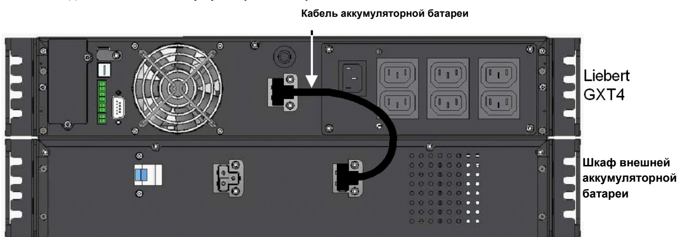
Рис.11 Соединение кабеля аккумуляторной батареи
