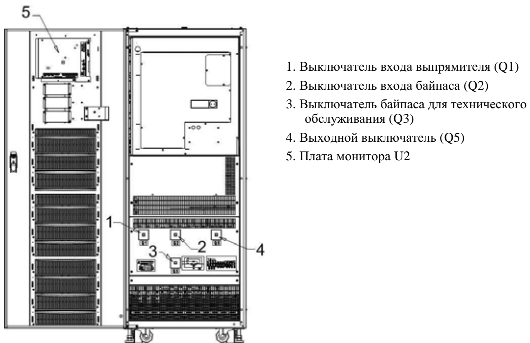
Рисунок 50 - ИБП NXa 100-120 кВА, вид спереди с открытой дверью
